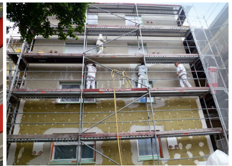
Links: Das weiß-grau-rote Farbkonzept entstand mit Unterstützung der Knauf Farbberatung. Der Grauton ist auf die am Hochkantformat erkennbaren solarthermischen Lüftungen abgestimmt. Oben: Zügiges Arbeiten mit vier Mann auf dem Gerüst sowie der Spritztechnik für Kleber und Mörtel – hier beim Auftragen des Armierungsputzes
